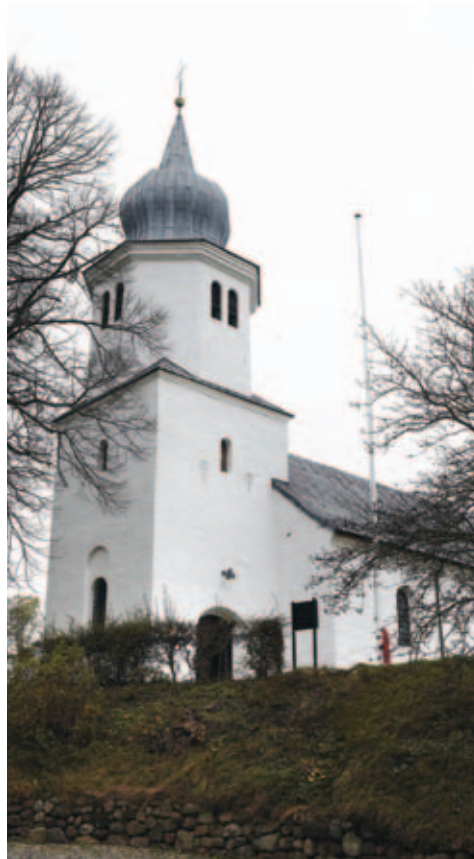
Middelalderkirken på bakketoppen i Nr. Galten bruges sjældent og står derfor uopvarmet det meste af tiden. Et højt vandtryk fra kirkegården og dårlige udluftningsmuligheder giver udfordringer med fugt.
